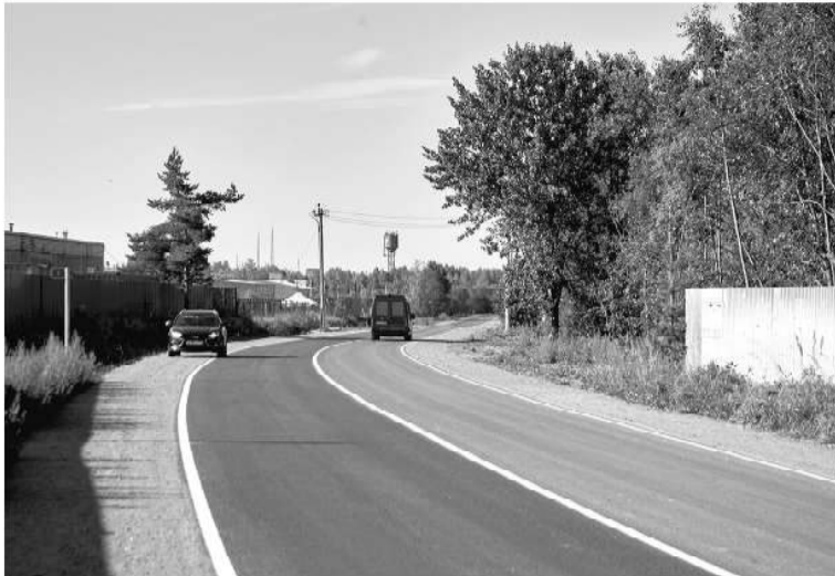
Ленобласть и Петербург сообща ремонтируют подъезды к садоводствам
