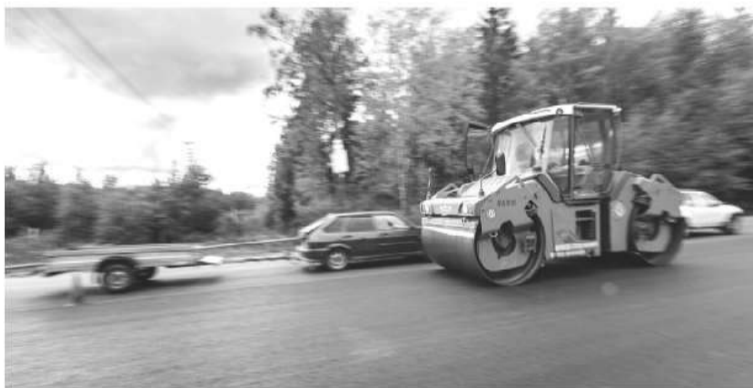
Строительство моста через Свирь идёт с применением технологии литого асфальта
