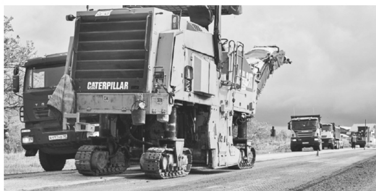
Дорожные работы на региональной трассе Лодейное Поле — Тихвин — Будогощь в Тихвинском районе
