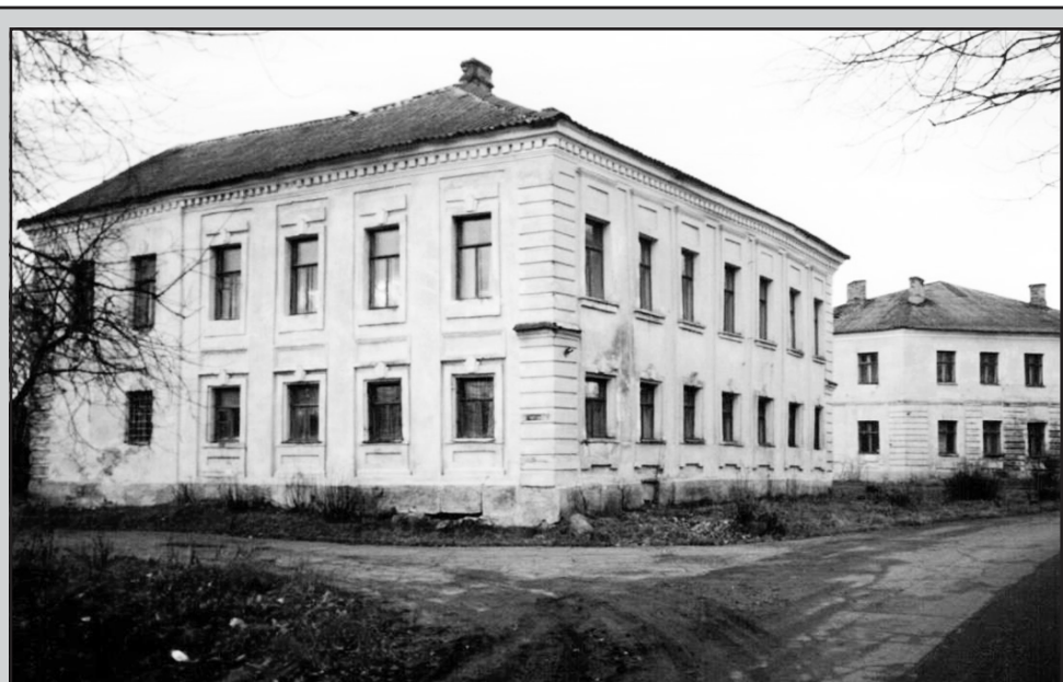
Эти два исторических здания второй половины XVIII века на перекрестке улиц Красной и МОПРа уже в течение нескольких лет стоят заброшенными, что вызывает большое опасение за их судьбу.
